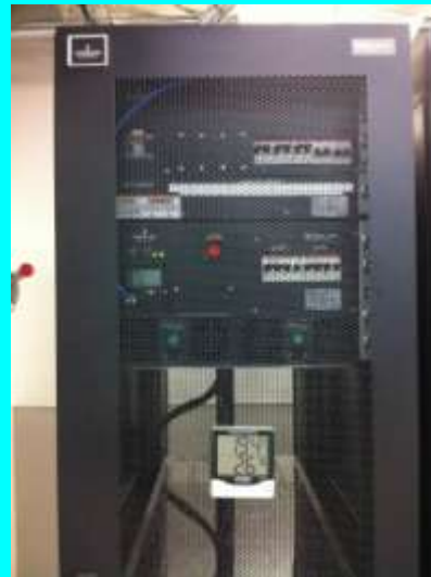
30kW Rectifier + Batteries
