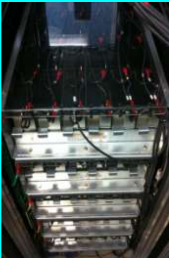
30kW Rectifier + Batteries
